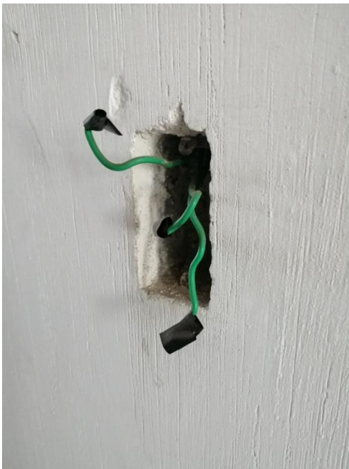
Imágenes 19, 20 y 21. En materia de instalaciones eléctricas se comprueba la falta de mantenimiento, sin que esto signifique un riesgo inmediato de incendio por corto circuito.
