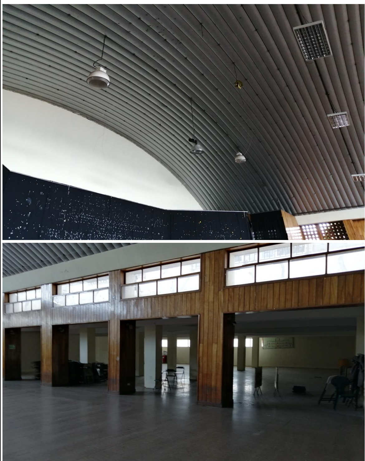
Imágenes 6 y 7. Edificio Complejo Social “José Luis Villatoro”, interior. 5ta Avenida “B”, 11 calle, zona 1, San Marcos, San Marcos, Guatemala. El interior de edificio cuenta con ventanas de aluminio, con luz artificial y entradas de luz natural. La iluminación del edificio no representa ningún factor de deterioro para los documentos.
