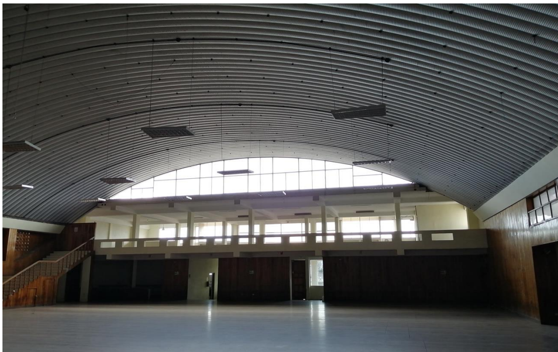
Imágenes 5 y 6. Edificio Complejo Social “José Luis Villatoro”, interior. 5ta Avenida “B”, 11 calle, zona 1, San Marcos, San Marcos, Guatemala. El interior del edificio evidencia la sólida construcción, con columnas de acero y concreto, techo curvo o “arcotecho” de lámina galvanizada.
