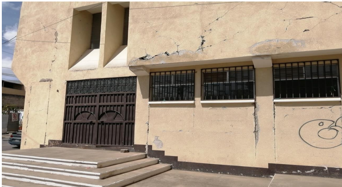
Imágenes 1 y 2. Edificio Complejo Social “José Luis Villatoro”, exterior.
