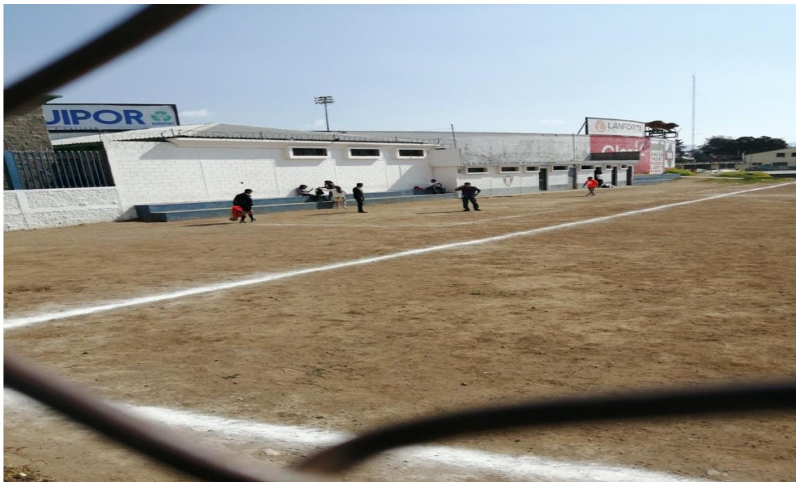
Imágenes 7 y 8. Edificio Complejo Social “José Luis Villatoro”, interior. 5ta Avenida “B”, 11 calle, zona 1, San Marcos, San Marcos, Guatemala. El edificio, en su entorno externo, colinda con instalaciones deportivas que no representan circunstancia de deterioro a los documentos en tanto el edificio y el depósito logran proteger los mismos.
