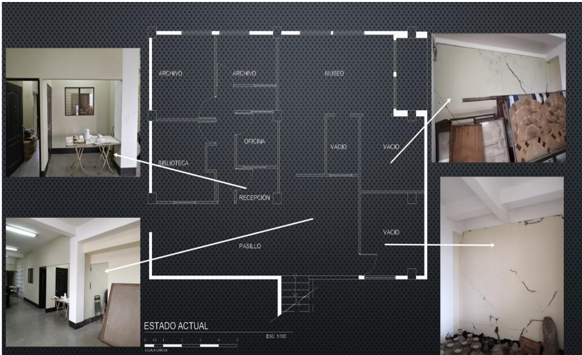
Ilustración 2 Paredes dañadas
