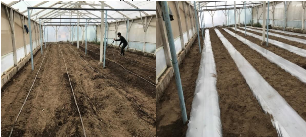
Fotografía 1. Instalación de riego por goteo
