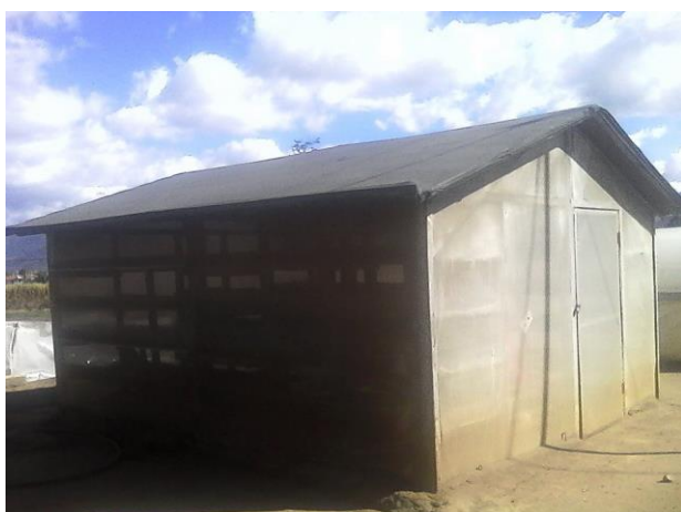
Ilustración 6. Estructura utilizada para almacenamiento de los tubérculos-semilla bajo luz difusa.
