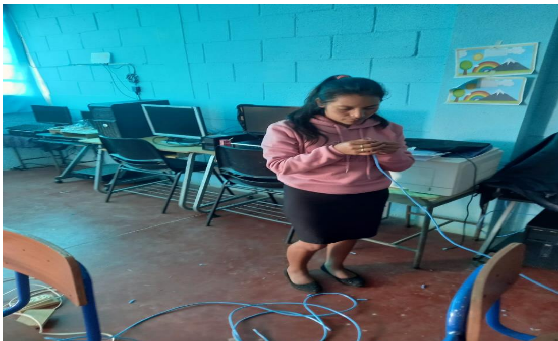
Foto: aquí me encontraba pelando los cables para después acomodarlos dentro de los prensadores y sucesivamente conectarlos.
