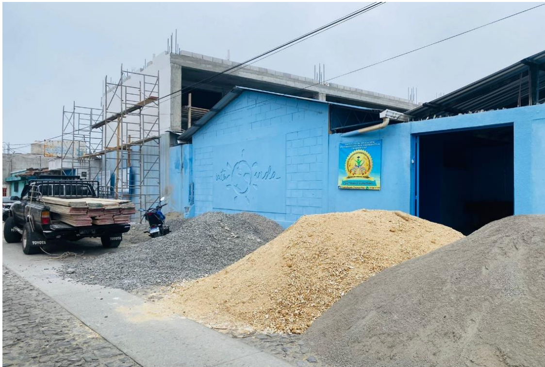
Ilustración 25 Vista de los materiales y las aulas nuevas desde la parte exterior del establecimiento.
