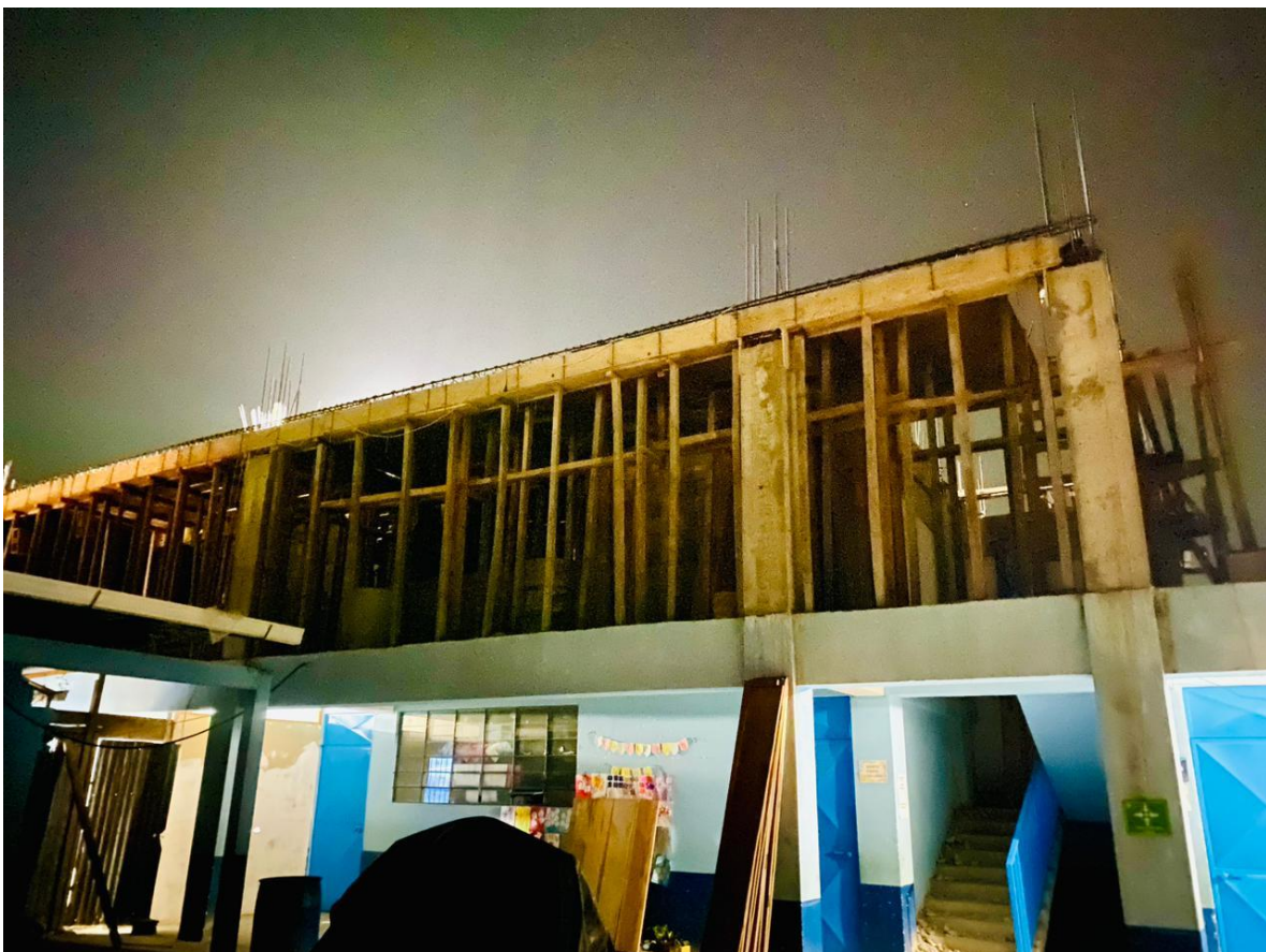
Ilustración 22 Preparación de los últimos detalles para la fundición de la terraza
