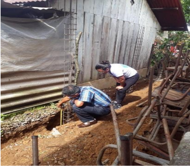
Ilustración 21 Fase de ejecución
