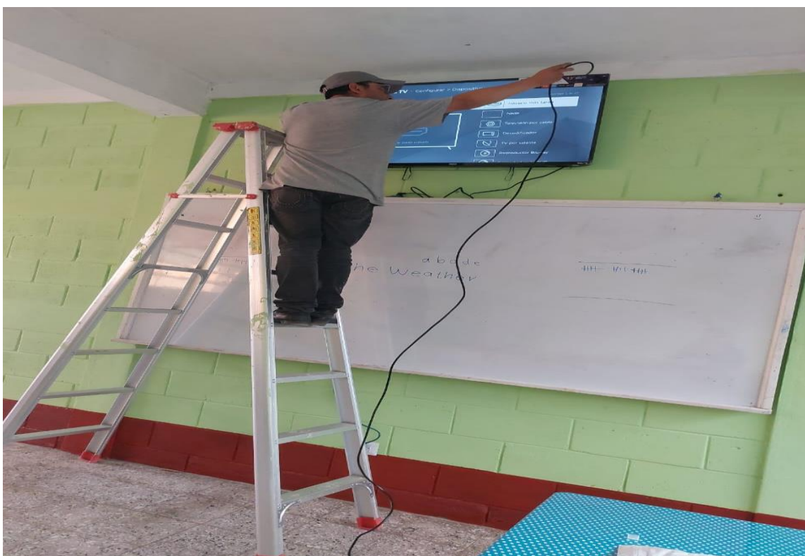
Ilustración 28. Colocación de los cables HDMI a las pantallas del Instituto.
