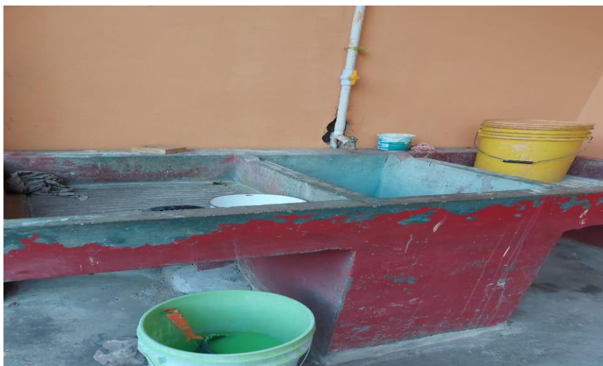
Ilustración 6. Actividad pedagógica 3. Remozamiento de pintura de pila.
