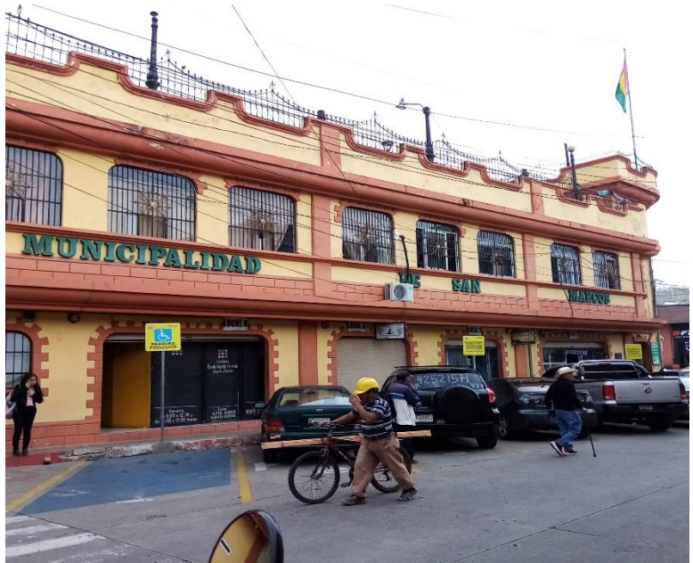
Edificio de la Municipalidad de San Marcos
