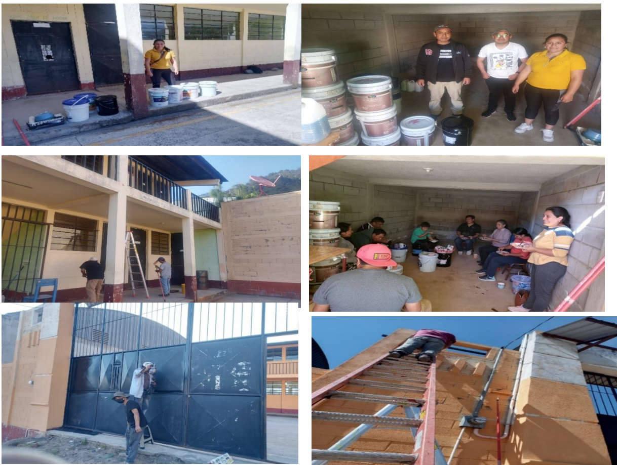
Ilustración 23. Ejecución del proyecto pedagógico
