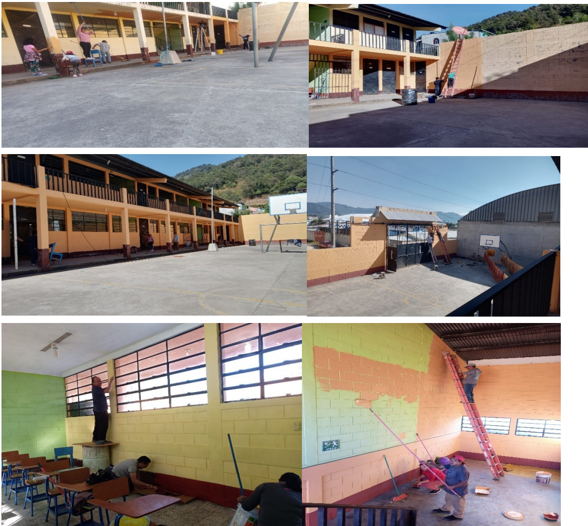
Ilustración 24. Ejecución del proyecto pedagógico.
